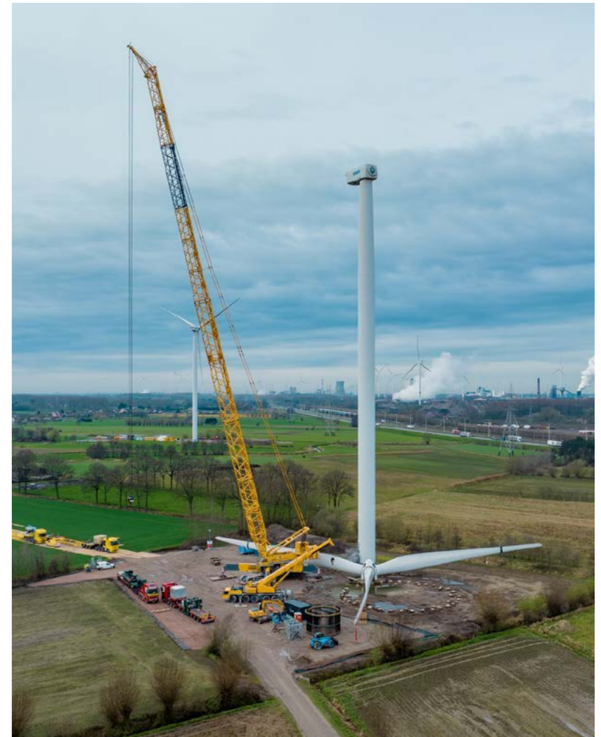
De demontage in Wachtebeke.
