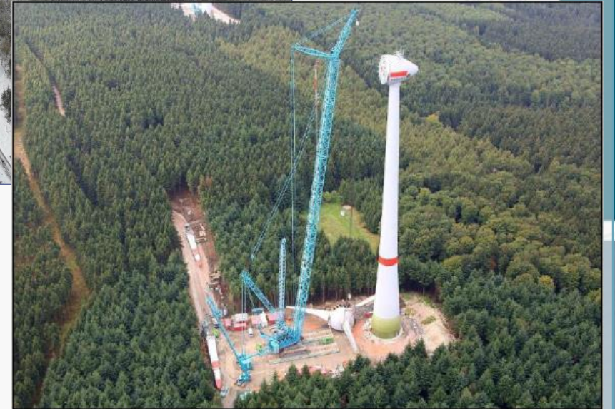
Construction d'une éolienne en zone forestière en Allemagne (source : www.juwi.de ).
